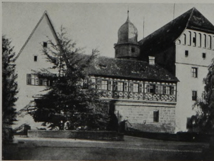
Abb. 3. Aus dem alten Palas der ehemaligen Kaiserpfalz wurde eine fürstbischöfliche Residenz. Eine ehemalige Wasserburganlage. Ueber der steinernen Front erhebt sich rein zimmermäßiges Fachwerk mit Kreuzbügen.
