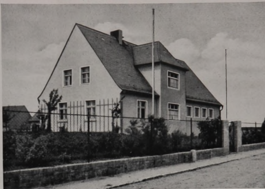
Schule in Naßbrockguth (Kreis Strehlen)
