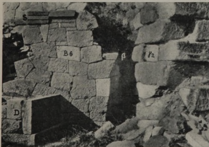
Der früh-archaische Stützmauerbau in Eleusis. Polygonal geformte Steine, vor der Baustelle behauen, häufig sogar geschliffen, setzten wohlausgebildete Steinmetzen voraus. Alter ca. 1200 v. Chr. Hochwertige Arbeit.
