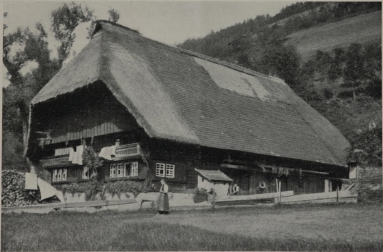
Schwarzwaldhaus in alemannischem Bundbau, Wände mit Bohlen ausgesetzt.
