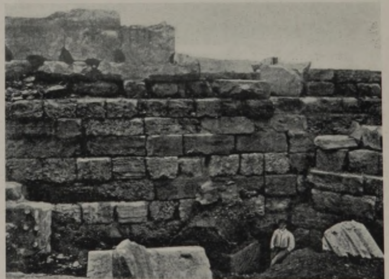
Technik des Stützmauerbaues 700 Jahre später. Die Steine dieser Stützmauer wurden im Schnellbetrieb von Kriegssklaven fabrikatorisch auf Vorrat hergestellt. Antike Normung, bei nicht vollwertiger Arbeit.
