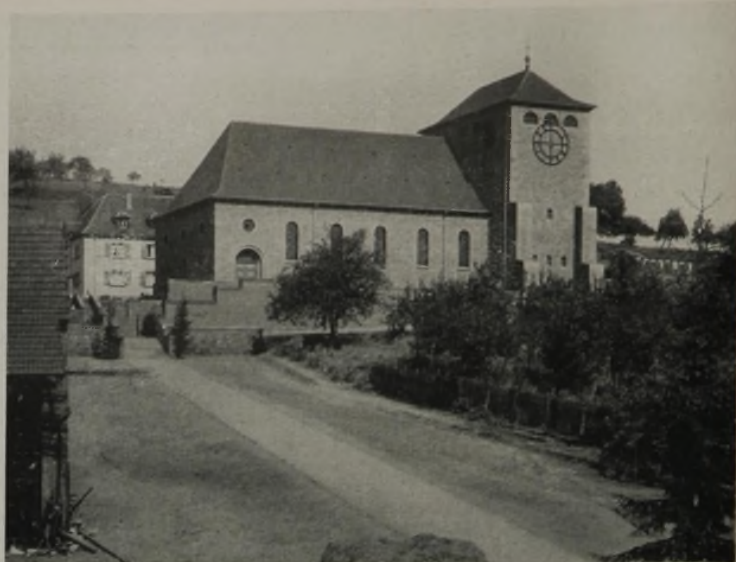
Klare, waagrecht gelagerte Baugruppe. Geschlossene Anlage; nur zwei Baukörper: Turm (mit Chor und Sakristei) und Schiff (Laienraum mit Windfängen und Empore). Die Eingänge liegen des Wetterschlages wegen auf der Nord- und Südseite.
