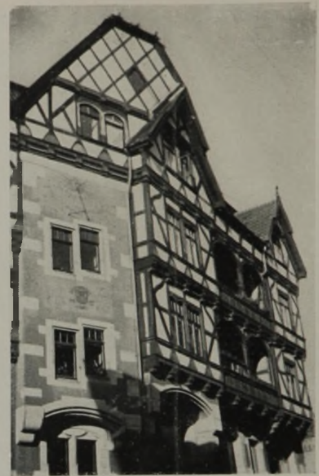
Ein Beispiel aus dem Ende der 90er Jahre zeigt die kleinliche und lediglich aus spielerischer Aeüßerlichkeit hervorgegangene Verbindung des Fachwerkes im Zusammenhang mit anderen Techniken, eine Mißhandlung des werkstoffmäßigen Aufbaues, die zur dauernden Verunstaltung einer großen Zahl unserer alten Fachwerkstädte geführt hat.
