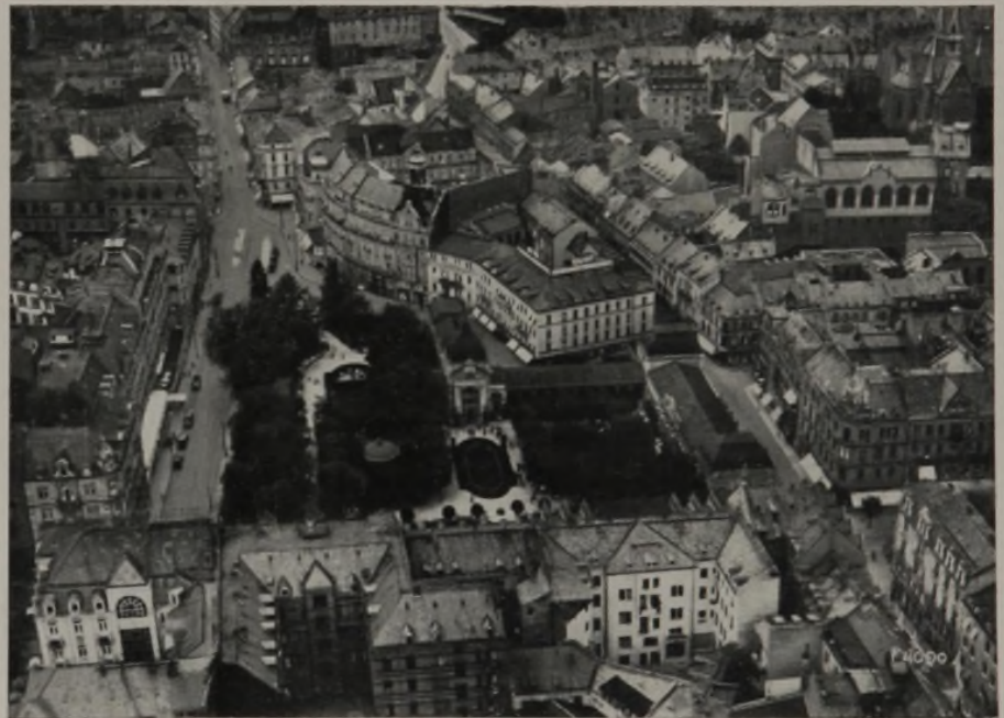
Die bestehende Kochbrunnenanlage von Nordost gesehen. Im linken Teil des Bildes Blick auf Kranzplatz und Langgasse. Im Mittelgrund rechts das vorspringende Hotel Römerbad. In der Mitte an die Platzwand gepreßt der Quellentempel. Rechts vom Hotel Römerbad mündet die Saalgasse ein. Die Rückfassaden im Vordergrund gehören zur Taunusstraße, welche nach links zur Wilhelmstraße (Kurahaus), nach rechts in das Nerotal führt.
