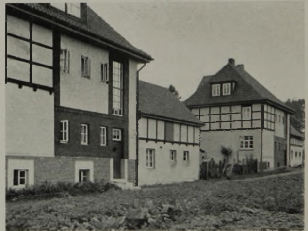
In dem Bestreben, etwas Auffallendes zu leisten, ist sowohl Fachwerk wie auch Klinkerstreifen ganz willkürlich und unorganisch angewandt. Die Unruhe und Unklarheit im Aufbau, die sich in der Verwendung verschiedenartiger Fensterformen zeigt, ist weiterhin noch in der Zusammenfügung von Haus und Anbau zu erkennen, die niemals zu einer wirklichen Formeinheit kommen.
