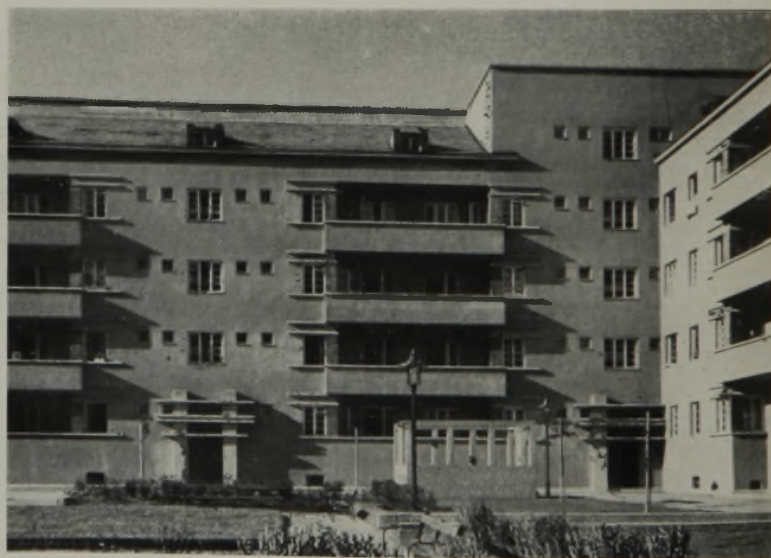
Blick auf einen Hofteil. Mehr als 100 Maschinengewehre dienten dazu, das eindringende Militär bei Sichtbarwerden auf dem Hofe zu erledigen. In den Betonkellern waren große Munitionslager, die auch von den schweren Minenwerfern nicht erreicht wurden.
