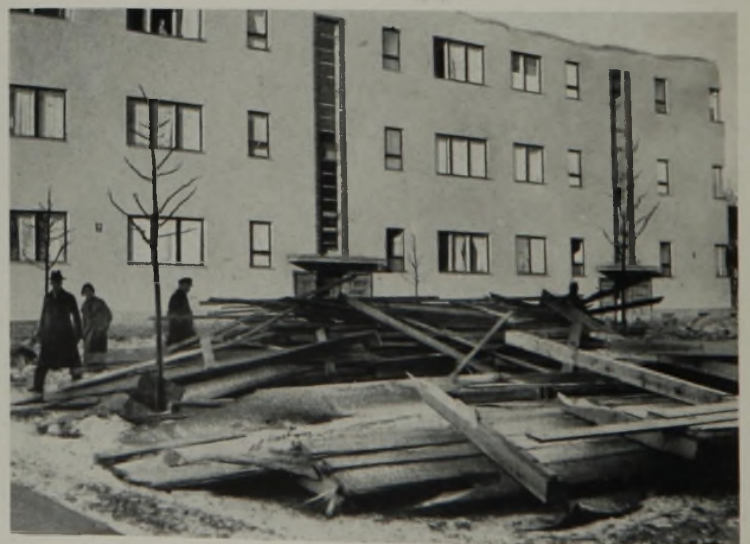
Abb. 3. Die Trümmer des abgeworfenen Daches in der Davoser Straße. Oben die Ruine der 1 Stein starken Drempe(mauer), aus der die Stielanker vom Sturm herausgerissen wurden, Teile der Mauer mitnehmend.
