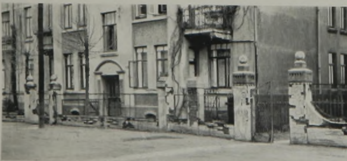
Abb. 3 ist ein Beweis dafür, daß Einfriedigungen aus Dutzendsteinen regelmäßig nach mehreren Jahren durch Frost zerstört werden; auch der beste Putz bildet Haarrisse, die den Verfall einleiten.
