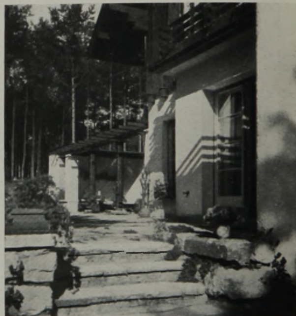
Unregel- mäßiger Platten- belag und roh be- kantete Stufen.
