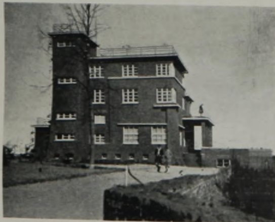
Die Jugendherberge in Alpen, Niederrhein, übersteigert die Terrassenidee zu einer unruhigen und in ihrem auffallenden Gebaren unerquicklichen Mischform von Turm- und Flachdachhaus, wobei z. B. in der einseitigen Emporführung eines Schornsteins die ungenügende Durcharbeitung des Grundrisses zu erkennen ist. Als mehrstöckiger, durch Terrassen verteuert Bau eine übertriebene Nachahmung von Hochgebirgshotels.
