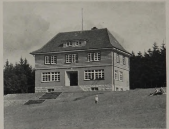
Die Jugendherberge in Hachenburg, Gau Main-Rhein-Lahn-Fulda, hat bei geringem Raumbedarf gute Abmessungen des Hauskörpers, der wie ein feineres Wohnhaus wirkt, auch das Dach für Aufenthaltsräume nicht beanspruchen will. Anlagen mäßigen Umfanges sind bei wechselndem Wanderverkehr wirtschaftlicher als allzu große Anlagen.
