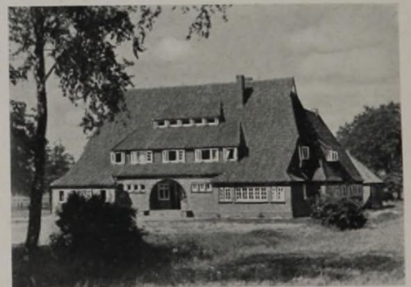
Die Jugendherberge in Worpswede, Gau Unterweser-Ems, hat durch die für ein Bauernhaus ganz ungewöhnliche Ausnutzung des Obergeschosses mit Schlafräumen eine verwinkelte Form mit zu vielen Dachausbauten erhalten. Diese Art der Verwendung von Bauernhausformen für ganz anders geartete Zwecke wird leicht zu Fehllösungen führen.
