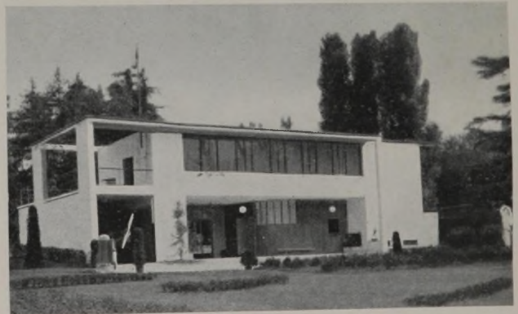
Ausstellungshaus von Arch. Scoccimarro, Zanini und Nidana, erregte auf der Aussellung als Zeugnis für die Betonplattenverwendung gebührende Bewunderung der Laien.
