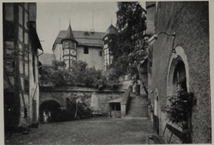
Oberer Schloßhof mit Fachwerktürmen am Westbau, durch den Brand dieses Jahres zerstört.
