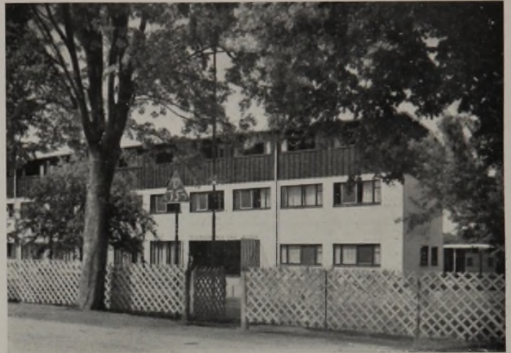
Straßenseite nach Süden.
