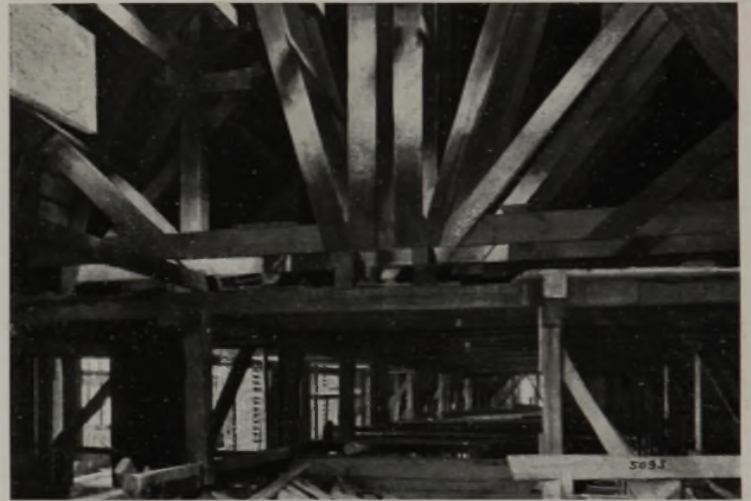
Knotendetail des Arbeitsgerüsts unter dem Kuppel-(Laternen-)aufsatz im Vergleich zum Bilde des Gesamt-Gerüsts (s. oben).
