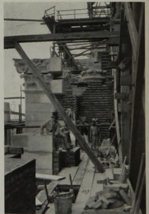
Sandstein- und Maurerarbeiten an der Fassade.
