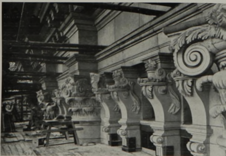
Bildhauer an der Arbeit an der Außenfassade.
