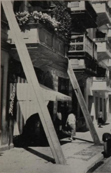
Abb. 1. Zwei starke Stützen an der Vorderfront des Berliner Hauses.
