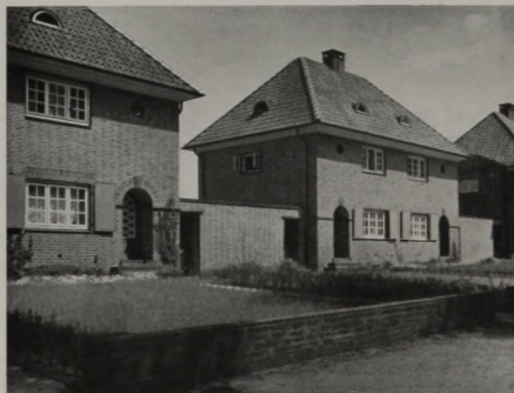
Die Häuser haben einen teppichartigen Vorgarten erhalten. Das schon an verschiedenen Stellen mit Glück angewendete Motiv der verbindenden Mauer ist nicht nur schön, sondern auch siedlungstechnisch erwünscht. Der Garten erhält dadurch seinen Privatcharakter.
