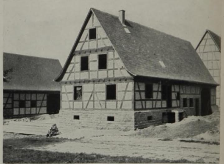
Abb. 1. Giebel- und Rückansicht eines erst im Rohbau erstellten Bauernhauses in Oeschelbronn (zu Abb. 1—9 gehörig). Baukosten (ohne Bauplatz und Anliegerbeiträge) RM. 17600,—.
