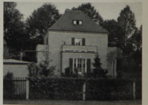
Abb. 4. Vor- und Anbau ohne Maßstab und Formensinn, die Anschlüsse Vorbau-Wand, Stütze-Platte, Stufe-Wangenbrüstung wollen durchgebildet sein, der Wechsel von Holz- und Putzbau (Hintergrund des Bildes) ist nur unter der Voraussetzung sicherer handwerklicher Uebung beider Ausführungen erträglich.
