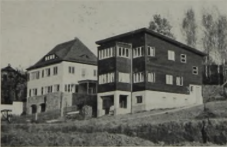
Abb. 1 a und 1 b. Unruhiges Durcheinander der Dachformen und der Fensteranordnung, bei a) die Giebelwand durch Vorbau beglückt, bei b) die Pergola vor Nebenräumen auf die Garage gebracht.
