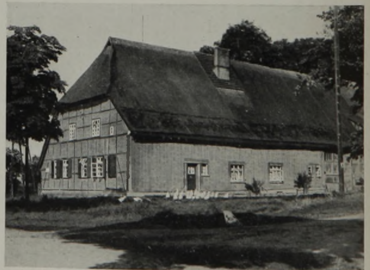
Abb. 2. Alte Rohrdachscheune, umgebaut zu einer Siedlerstelle. In den vorhandenen Scheunenraum wurde die Wohnung und der Stall eingebaut.
