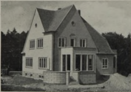
Abb. 1 a und 1 b. Unruhiges Durcheinander der Dachformen und der Fensteranordnung, bei a) die Giebelwand durch Vorbau beglückt, bei b) die Pergola vor Nebenräumen auf die Garage gebracht.
