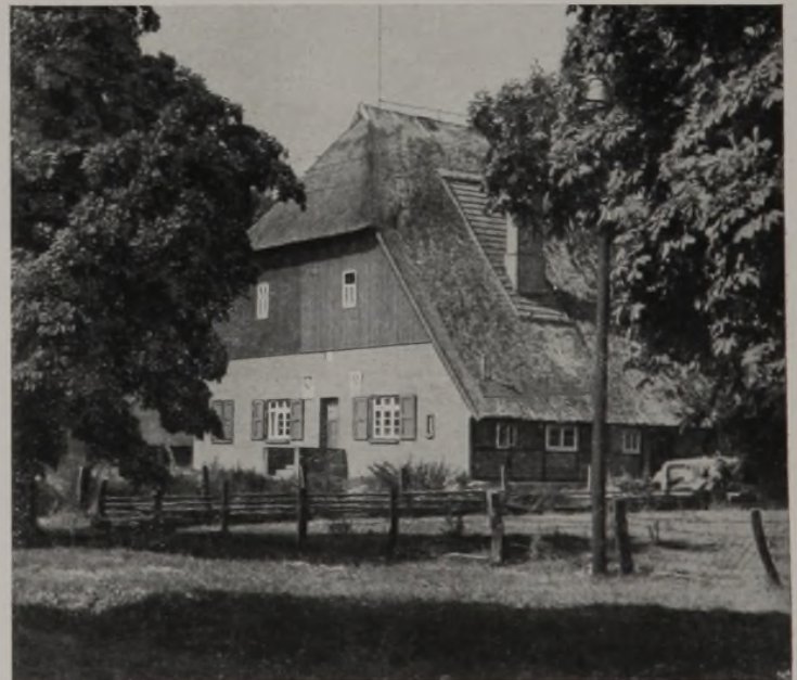
Abb. 4. Alte Rohrdachscheune, ausgebaut zu einer 80-Morgenstelle. Etwa \frac{1}{3} der Scheune war baufällig und wurde abgebrochen. Es mußte ein neuer Giebel hergestellt werden. Eine geräumige Wohnung und ein ausreichender Stall wurde außerdem neu eingebaut.
