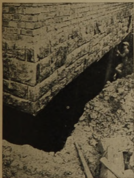
Äußere Vertikal-Isolierung einer Wohnhaus-Kellerwand mit 2maligem Aristogen-Anstrich (1 x verdünnt, 1 x Aristogenstreichmasse)
