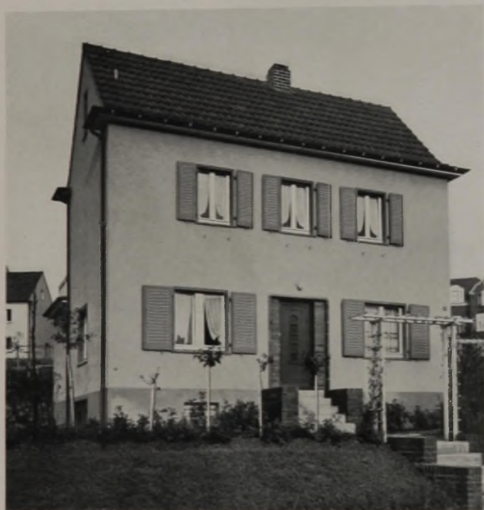
Einfamilienhaus. Umbauter Raum 383 cbm. Baukosten 8130 R.M.
