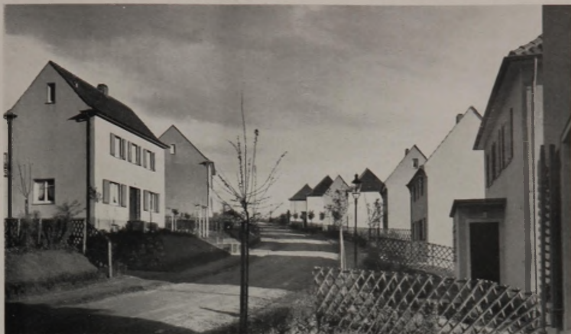
Dieselbe Straße, die an geböschter Kurve zum Höhenrücken führt. Um den Häuserbau erschwinglich zu machen, mußte Grundstück und Größe rechnerisch erwogen werden. Die aufwärts gehende Straße erhielt eine schon in wenigen Jahren schön wirkende Baumreihenpflanzung.
