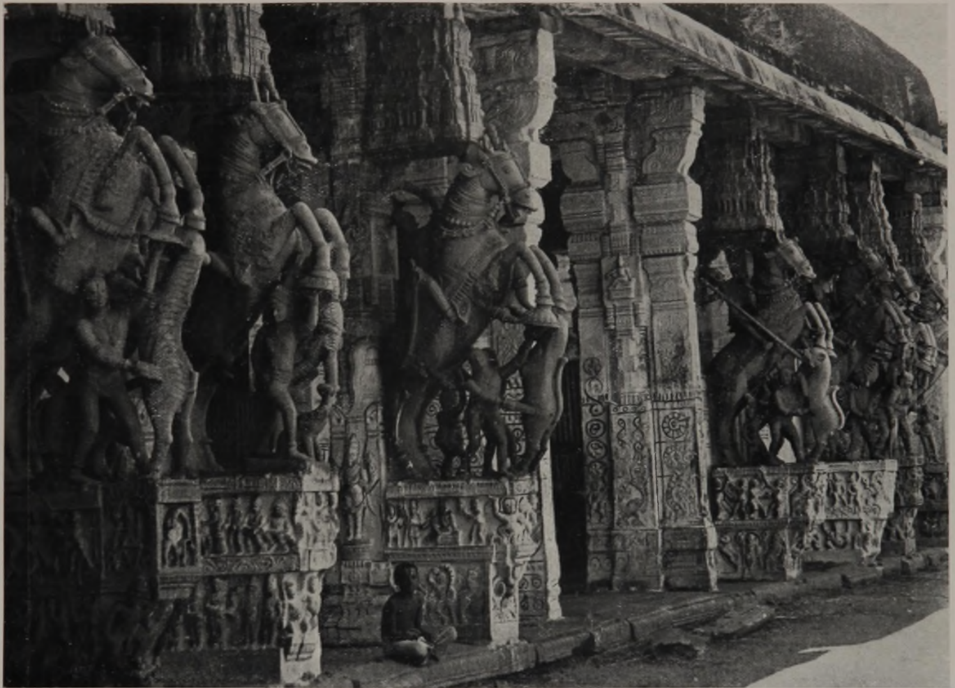
Aus der 1000-Pfeiler-Halle (137 × 39 m). Bilder und Symbole waren zugleich Zeugnisse der Religion. Der untiertötende Vorläufer des Ritters mittelalterlicher Zeit. Gebälk und Gesims in Naturstein als Nachbildung der Holzausführung älterer Zeit, Gesims mit glatter Stuckverzierung als Abdeckung. Säulen und Pilaster mit richtiger Fundamentierung. Sockel für Tiergestalten nur auf Bodenplatte gesetzt, daher Senkung und Neigung, rechts sichtbar.
