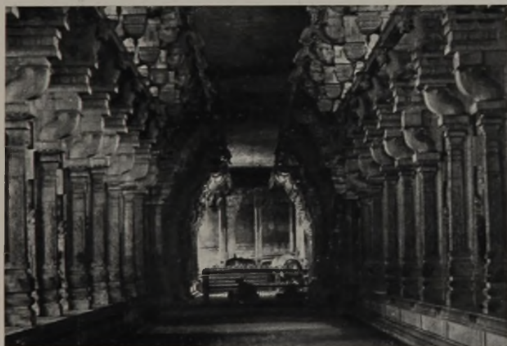
Aus der Tausend-Pfeiler-Halle von Tiruchinapalli. Ein Zugangsteil zum eingegitterten Priesterheiligtum, Pfeiler mit sehr zarten Reliefs. Ausführung mit den breiten Ueber- kragungen und alten Holz-Stabdecke.
