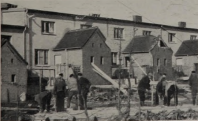
Dach in der ganzen Fläche abgehoben, überschlagen und über die Anbauten hinweg abgerutscht. Dachüberstand ohne Mauerbefestigung für Sturm leichte Angriffs- und Hubfläche und Flachdachsaustrahlung der abgelenkten und veränderten Windströmung als Zusatzkraft der Zerstörungen und des vollständigen Ueberschlagens. Flachdächer dieser handwerkswidrigen Ausführung sollten keine Genehmigung finden oder doch stärker mit den Mauerkörpern verbunden sein.
