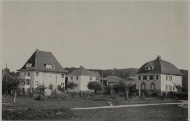
In Material, Form und Maßstab (!) fällt hier alles auseinander. Wie soll der Architekt bauen, der in diesem Wirrwarr einen Bau aufzuführen hat!
