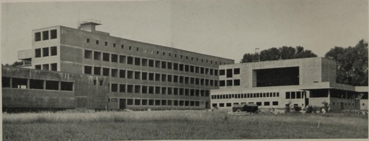
Nüchternste Elementarbauerei, mit der eine Fabrik nachahmenden Abwicklung. Endlose Serienfenster. Foto: Sommer. Der Seitenflügel mit dem 17-m-Aulafenster und die Dachgestaltung klagen die technische Unreife an.
