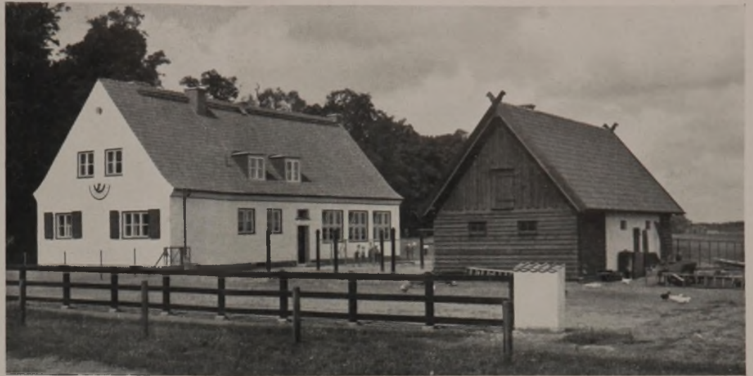
Fotos: Stadt. Hochbauamt.
