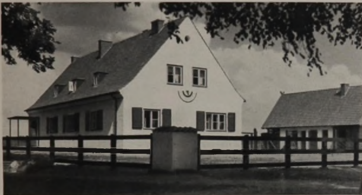
Der Zaun ist ein einfacher Bohlenzaun, der durch eine dahinter gepflanzte Hecke im Laufe der Zeit seinen richtigen Anschluß erhält.
