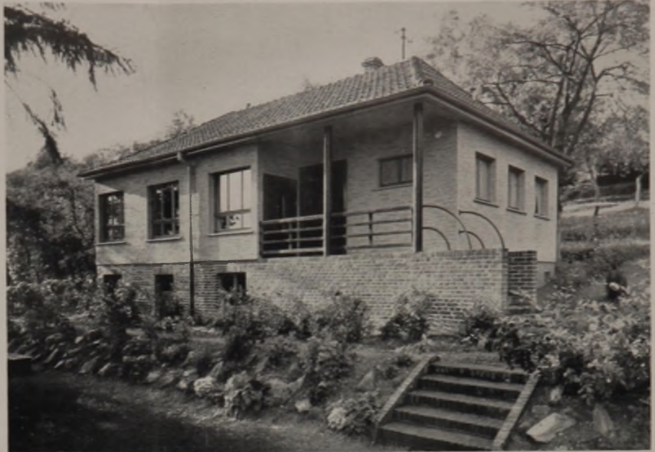
Fotos: L. Schilling, Bad Soden.
