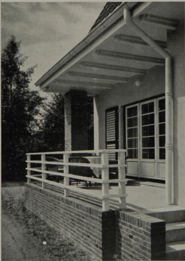
Eine bequeme Terrasse steht in unmittelbarer Verbindung mit dem Esszimmer. Früher brachte man hier ein Ziergitter mit Rosetten und Ranken an. Das heute vielfach verwendete Holzgeländer, immer horizontal gegliedert, soll in seinem offenen Charakter die Einfachheit und Billigkeit der Ausführung andeuten.
