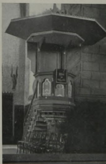
Abb. 5. Verbesserter Schalldeckel der evangelischen Kirche in Hannover-Herrenhausen.
