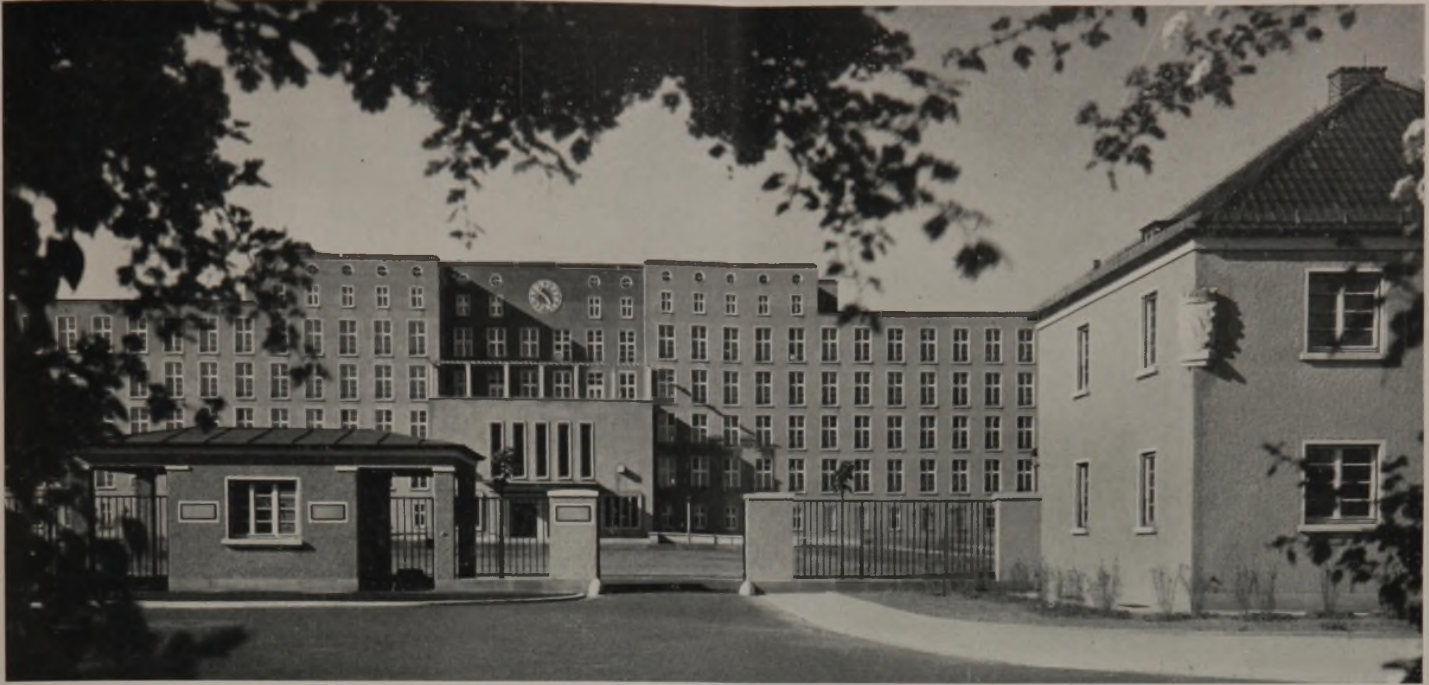
Hauptfront von Süden. Im Vordergrund axial liegendes Pförtnerhaus mit Ein- und Ausfahrt, rechts Beamtenwohnhaus mit dem bayrischen Staatswappen in Muschelkalk als Eckkartusche. Im Hintergrunde zurückgezogener sechsachsiger Mittelbau mit Uhr und vorgezogener Kapellenbau mit Veranda. Unmittelbar seitlich die gleichhohen fünfachsigen Flügel des Mittelbaues mit 6 Obergeschossen. Baukonstruktion: Tragende Backsteinmauern (nicht Skelettbau) und durchgehende Eisenbetonhohlsteindecken, allseitige Schallisolierung. Tönung aller Gebäude: aligold, Putzart: Terranova-Kellenwurf, extragrob. Anzahl der Krankbetten: 420, der Personalbetten: 80.
