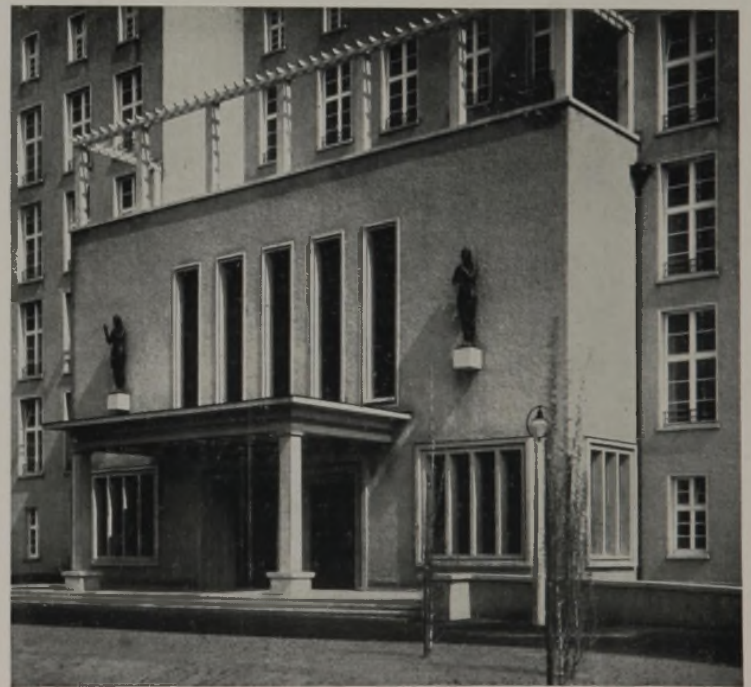
Mittelbau des Hauptgebäudes. Die Hauskirche ist hier unmittelbar über den Eingang angeordnet mit 5 langgezogenen farbig verglasten Fenstern. Seitlich der Fenster die Bronzen der „Hoffnung“ und „Erfüllung“ des Bildhauers Karl Bösenacker. Zweisäulengestützter Vorbau mit Glasprismen überdeckt als Anfahrt.
