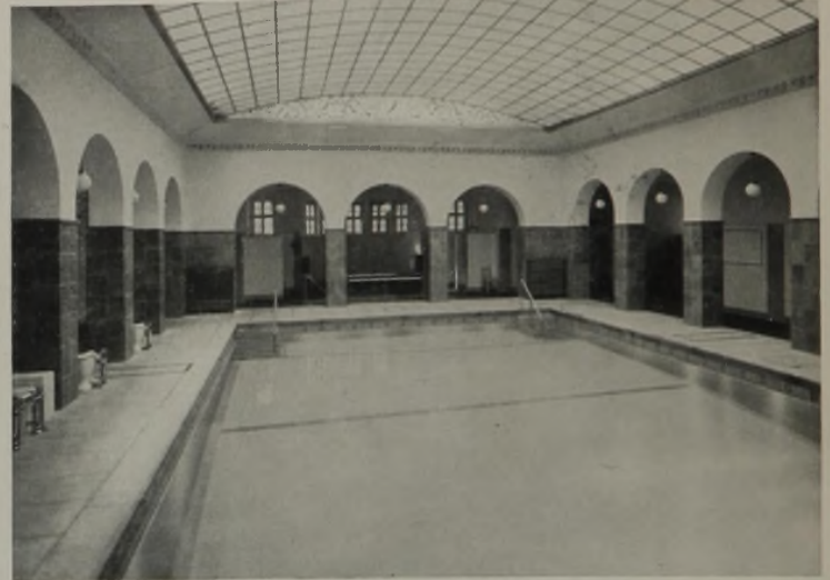
Die Schwimmhalle gegen Westen. Das Becken ist 8 m breit und 12,50 m lang. Die Halle ist mit Fliesen ausgekleidet. Im Hintergrund unter dem Laubengang ist je ein kleines Kalt- und Warmbecken.
