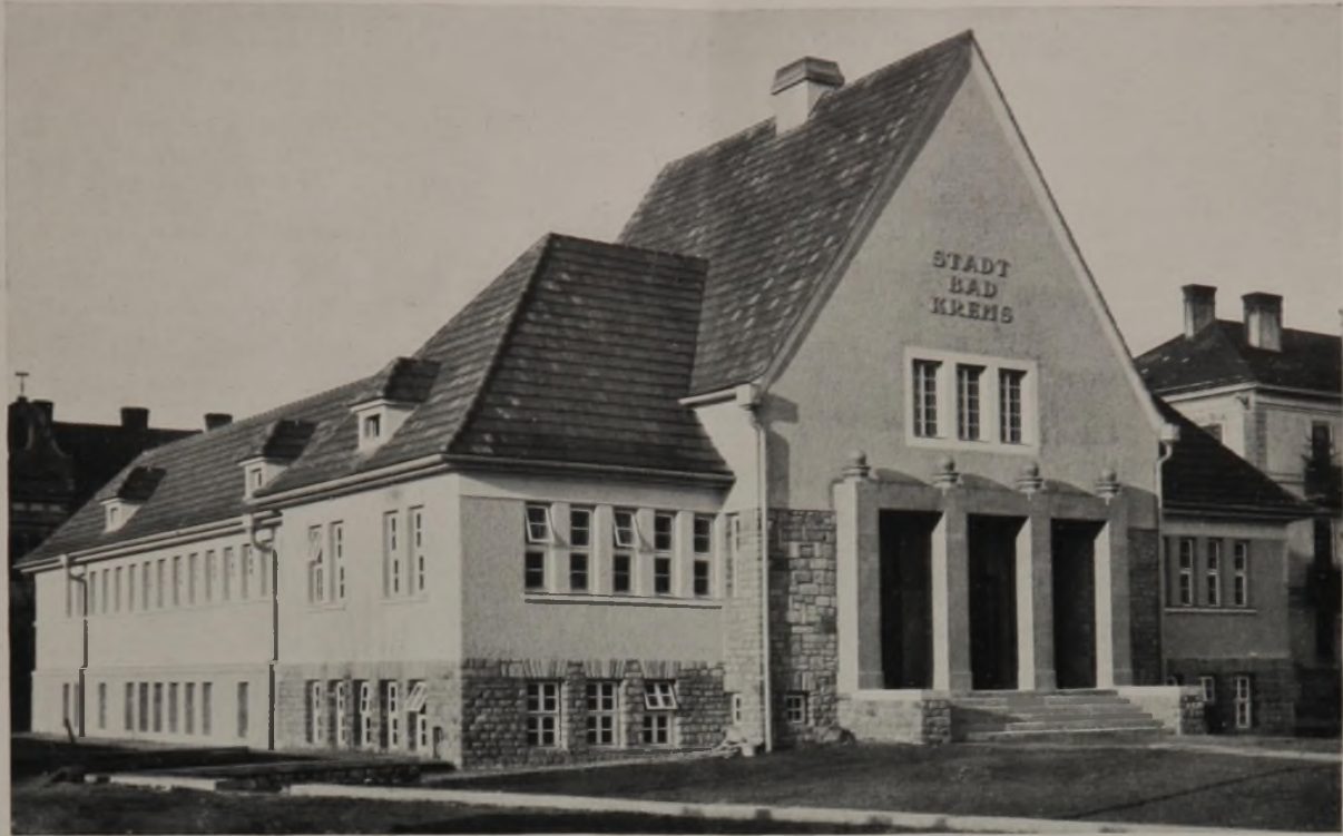
Ansicht des Stadtbades in Krems. Bruchsteinsockel aus bläulichem Urkalk, Umrahmung des Einganges aus blaugrünlasierten Tonfliesen. Dacheindeckung geradendigende Biberschwänze, sog. Wiener Taschen, in Kroneneindeckung.
