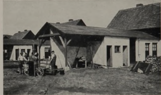
Abb. 5. Not- und Behelfswohnung Hameln. Nachträglich angebautes Stallgebäude mit Schuppen.
