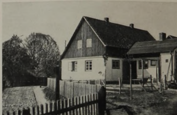
Abb. 3, 4. Stadtrandsiedlung Hameln. Stalldach überstehend, Abort am Stallende seitlich angebaut.
