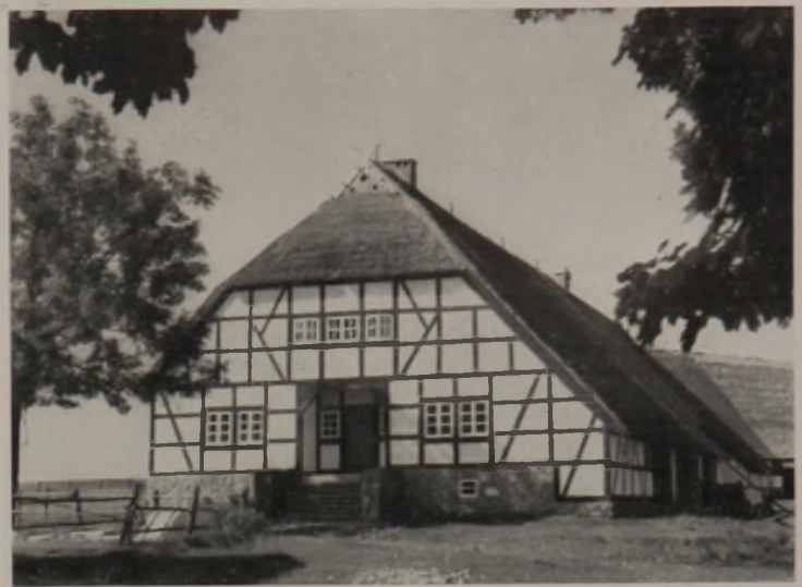
Ehemalige Scheune mit Reitbahn in Grüssow, umgebaut zu einer 160 Morgen großen Bauernstelle. Das Giebelfachwerk wurde teilweise neu abgebunden. Der Walm mit den Pferdeköpfen neu hergestellt. Im Giebel lassen sich weitere Stuben ausbauen. Küche, Futterküche und Speisekammer sind unterkellert.
