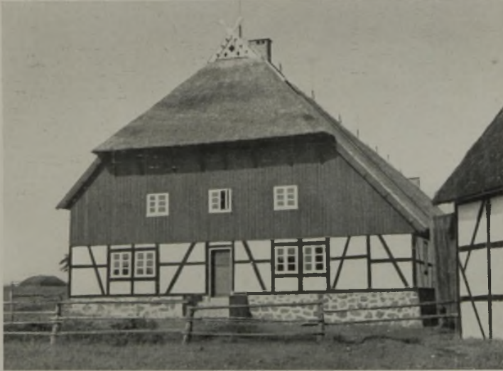
Giebelansicht des ehemaligen Schafstalles in Grüssow, umgebaut zu zwei Bauernstellen, je 100 Morgen groß. Der obere Teil des Giebels wurde verbrettert und mit dunkelbraunem Karbolineum gestrichen. Der Walm mit den Pferdeköpfen wurde neu hergestellt. Im Dachgeschoß lassen sich später weitere Giebelstuben ausbauen.
