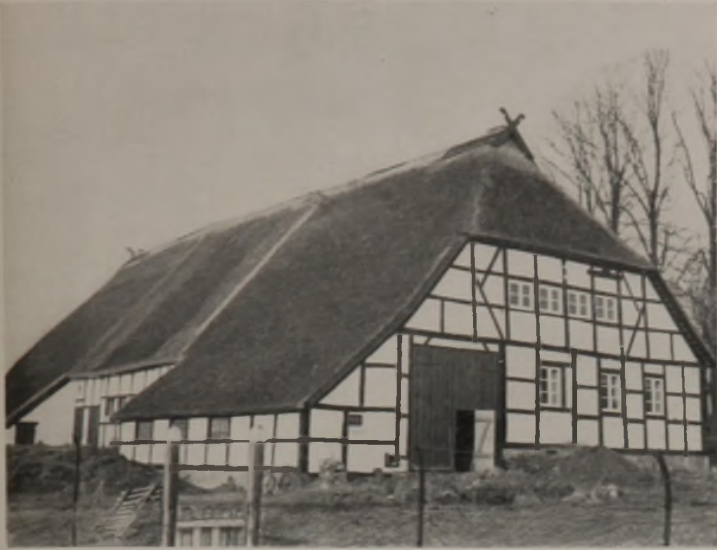
Ehemaliger Schafstall in Dreetz, umgebaut zu zwei Bauernstellen, je 60 Morgen groß. Zur Belichtung des Stalles wurde ein Stück aus der tief heruntergezogenen Dachfläche herausgeschnitten. Das alte Tafelmauerwerk wurde zweimal geweißt. Das Holzwerk mit Karbolineum unter Zusatz von Holzteer gestrichen.
