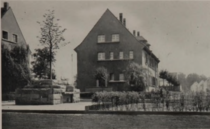
2 Vollgeschosse, ausgebautes Dachgeschoß mit tief eingeschnittenen Erkern und Winkeln. Erste Anlage.
