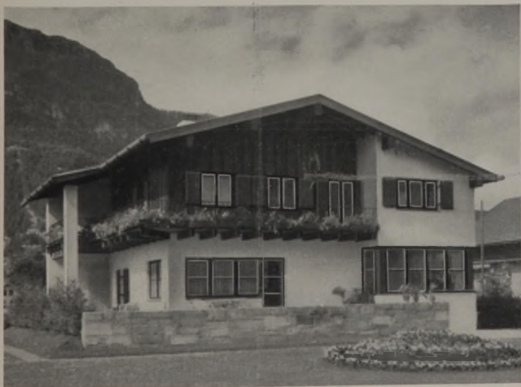
Gartenseite und Eingang (rechts). Die typischen Gebirgs-Balkonbrüstungen in Holzmaßwerk sind durch Eisengitter ersetzt. Die Blumen bereichern das Hausbild. Die althergebrachte Dachabdeckung mit Schindeln ist hier durch Blech ersetzt. Bergdorfübliche Verlängerung der Rinne als Wasserspeier.
