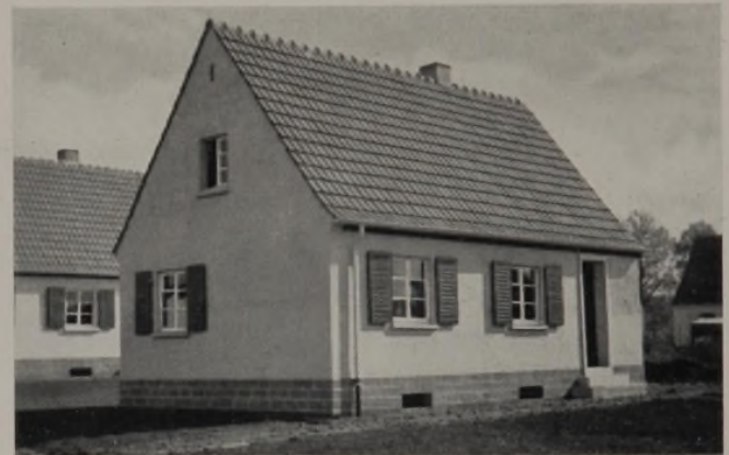
Photos: Hochbauamt Kaiserslautern.
