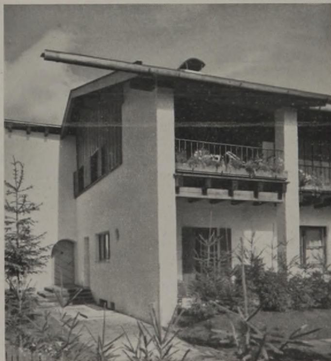
Gartenseite und Eingang (rechts). Die typischen Gebirgs-Balkonbrüstungen in Holzmaßwerk sind durch Eisengitter ersetzt. Die Blumen bereichern das Hausbild. Die althergebrachte Dachabdeckung mit Schindeln ist hier durch Blech ersetzt. Bergdorfübliche Verlängerung der Rinne als Wasserspeier.
