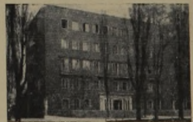
Verwaltungsgebäude der Rhein-Main-Donau-A.-G., München, mit Keimfarbe gestrichen
