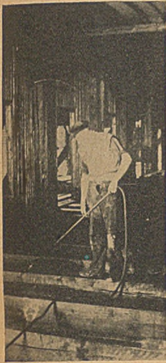
7 Hausbockbekämpfung im Spritzverfahren. Aufnahme: Ebert, Kassel
