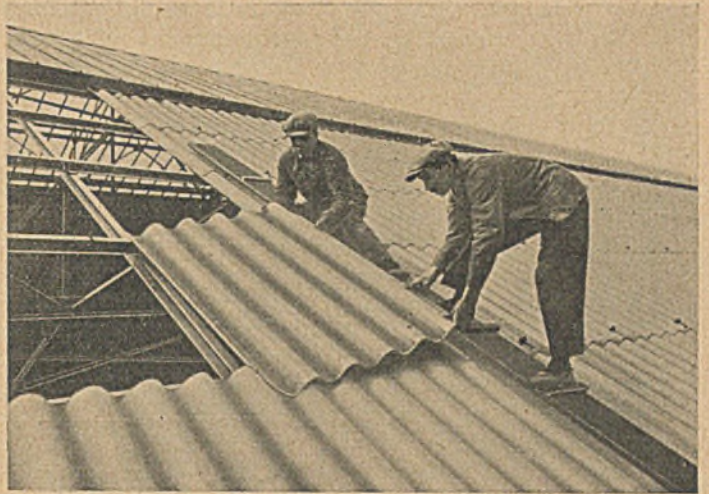
Verlegung von Welleternit (Austausch von Wellblech)
