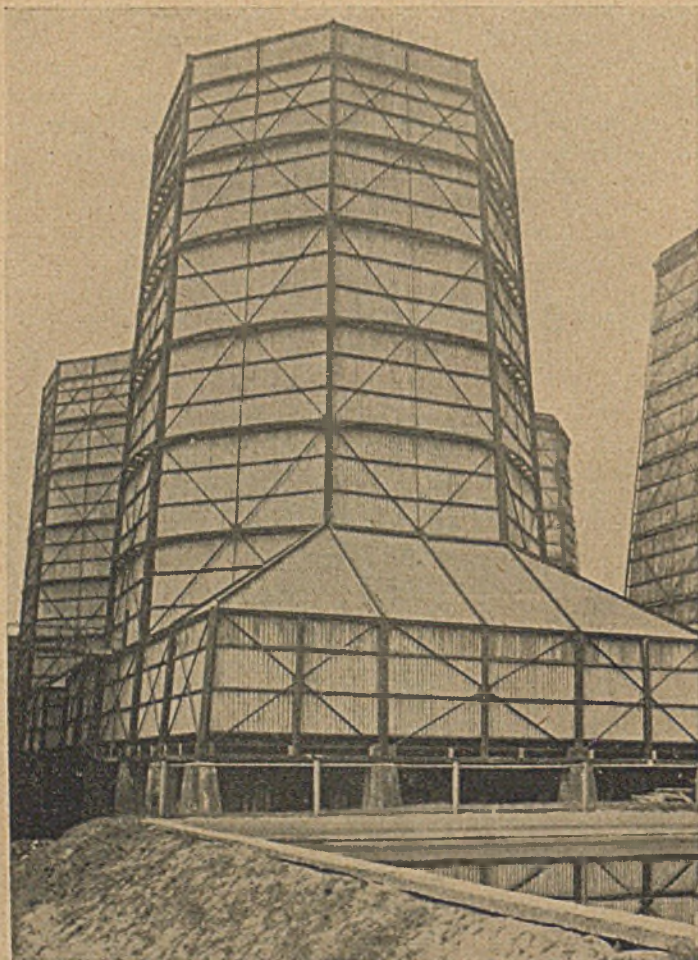
Kühlturm mit Verkleidung aus Welleternit
