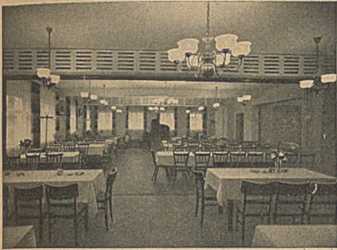
Entlüftungsleitung (Eternit) im Gasthaus „Zum Ochsen“ in Schnait bei Stuttgart
