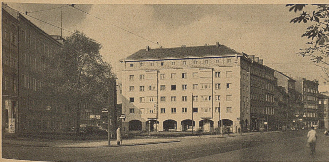
Blick auf den neuen Baublock am Johannisplatz. Die Häuser nehmen am Platz die Höhe des 5\frac{1}{2} geschossigen Nachbarbaues auf. Der Laubengang ergab sich zwangsläufig, da ein Vorrücken der Fußwegbordkante wegen des Zugangs zur daneben liegenden Opelgarage nicht möglich war.
