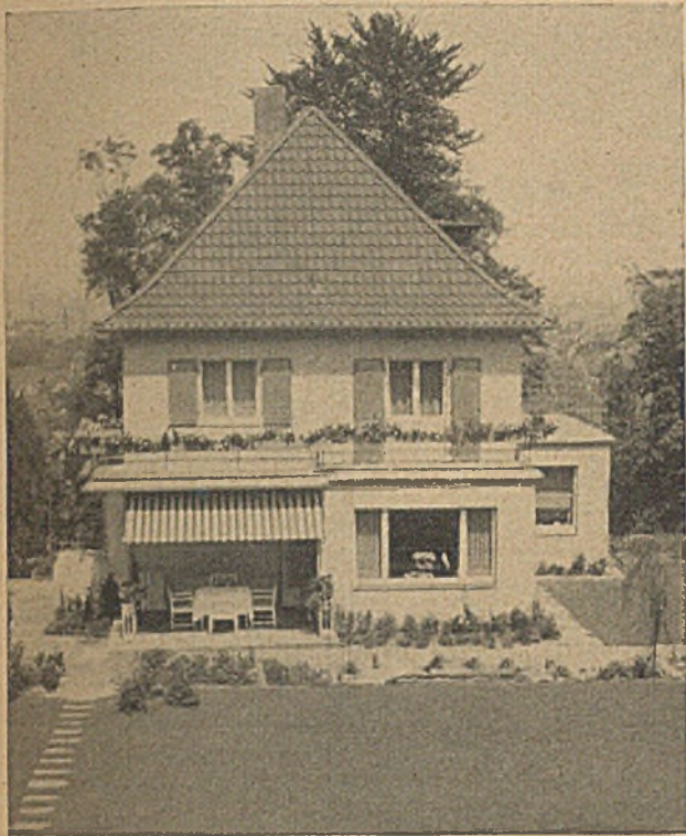
WOHNHAUS ARCHITEKT H., BIELEFELD Dachgeschoßräume, Balkone und Kellerfußböden mit Heraklith gedämmt
