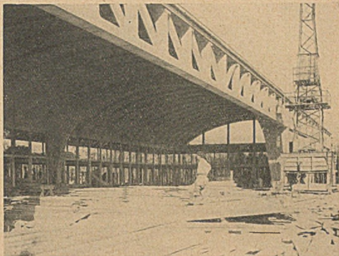
9 Halle mit Fachwerkbalken gemäß Abb. 7 und 8
