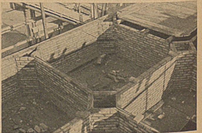
5 Schalungsgerippe des Saugschlauches eines Kraftwerkes
