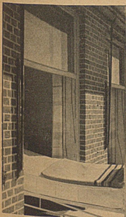
3 Dreiflügliges Durchgangsfenster im Kreiskrankenhaus Pinneberg. Bauart Stumpf
