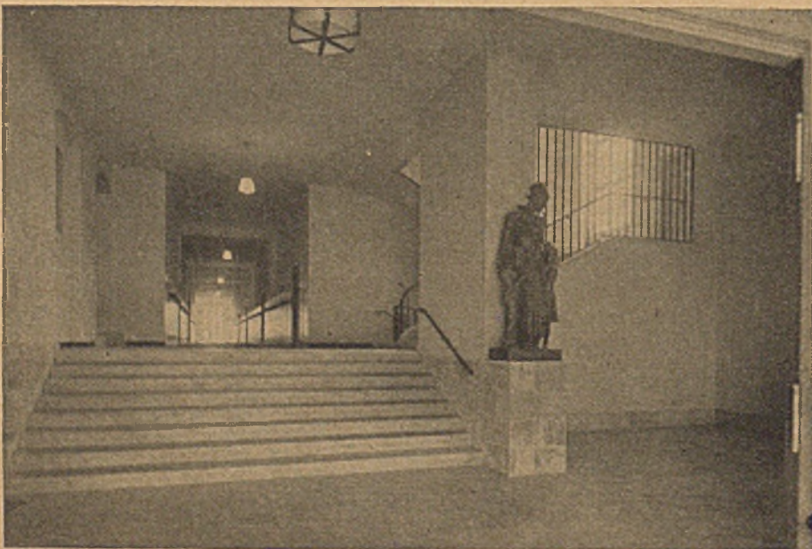
14 Eingangshalle mit Plastik. Architekt, Stadtbaurat a. D. Dr.-Ing. Erbs. Mitarbeiter Bauinspektor Stewert und Dipl.-Ing. Hesse
