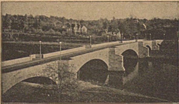
Martin-Mutschmann-Brücke über die Mulde in Rochlitz/Sa. Entw.: Sächs. Straßenbaudirektion in Dresden. Werkstein: Rochlitzer Porphy r (der größte Teil der Quaderung seit 500 Jahren bereits an der alten Brücke verwendet gewesen)
