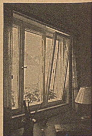
Fenster mit Roto-Drehklapp-Beschlag. Links: die Drehstellung bei „gut Wetter“. Ist diese Stellung zu „windig“, so gibt der „Dreh-Klapp“ die Möglichkeit, durch zwei Handgriffe die zugfreie Kippstellung einzustellen
