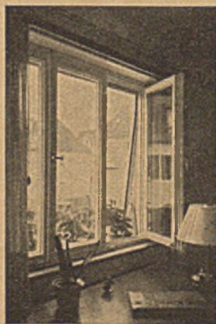
Fenster mit Roto-Drehklapp-Beschlag. Links: die Drehstellung bei „gut Wetter“. Ist diese Stellung zu „windig“, so gibt der „Dreh-Klapp“ die Möglichkeit, durch zwei Handgriffe die zugfreie Kippstellung einzustellen
