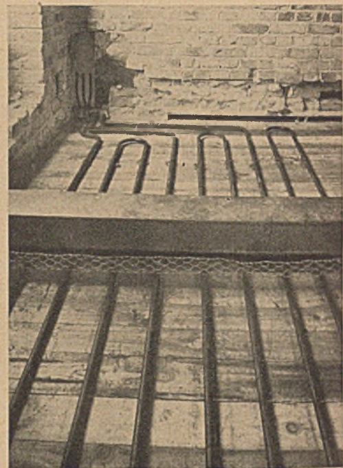
Frisch verlegte Heizrohrschlangen auf Deckenschalung im Wohnhausbau
