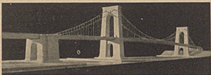
Modellaufnahme der Hamburger Elbehochbrücke. Stützweiten: 275+700+275 m. Hauptträger-Mittenabstand: 36 m. Höhe der Pylonen: 180 m. Veranschlagte Bauzeit: 7 Jahre
