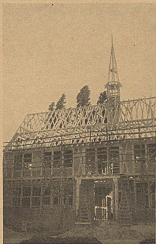
Gemeinschaftshaus der Siedlung des Gauheimstättenamtes im Rohbau
