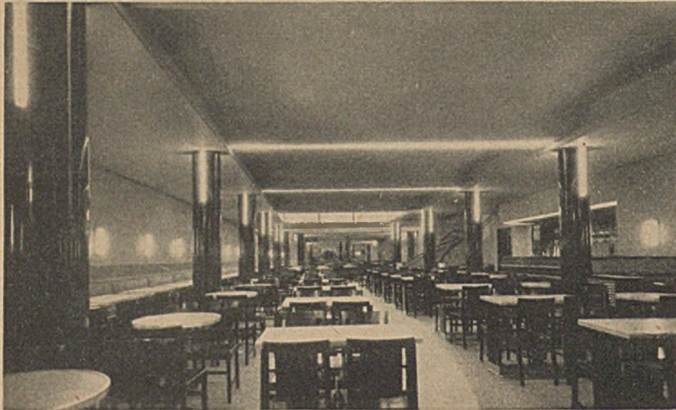
Neuzeitliche Beleuchtungsanlage für ein Café. Linestraröhren am oberen Teil der Säulen. An den verkleideten Querträgern befinden sich ebenfalls aus Linestraröhren gebildete Leuchtlinien. Freundlich wirkende Leuchten mit Opalhüllen schmücken die Wände
