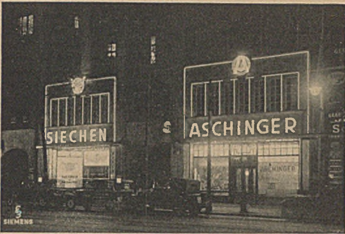
Rheingoldhaus, Berlin. Anlage aus Neonleuchtrohren
