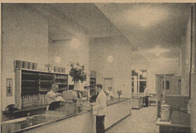
Einfache, zweckmäßige Beleuchtungsanlage in einem Aschinger-Ausschank; die Opalglass-Kugelleuchten über dem Schanktisch ermöglichen gute Sicht. Aufnahme: Dulsky, Berlin
