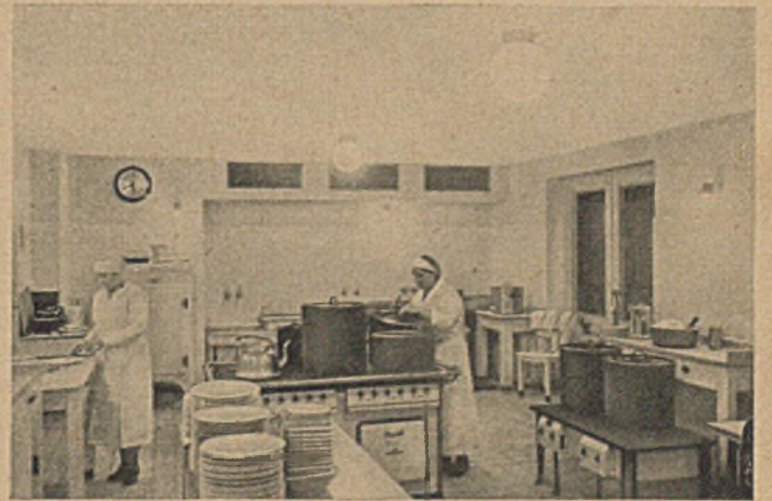
Vorbildlich beleuchtete Großküche. Opalglass-Kugelleuchten an der Decke und gleichartige Wandleuchten über jedem Arbeitsplatz ermöglichen mit ihrem blendungsfreien Licht schnelle, saubere Arbeit. Aufnahme: Dulsky, Berlin
