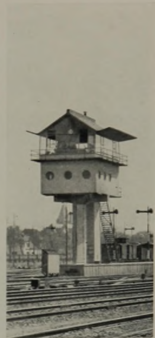
Stellwerk Maastricht, Außenansicht
