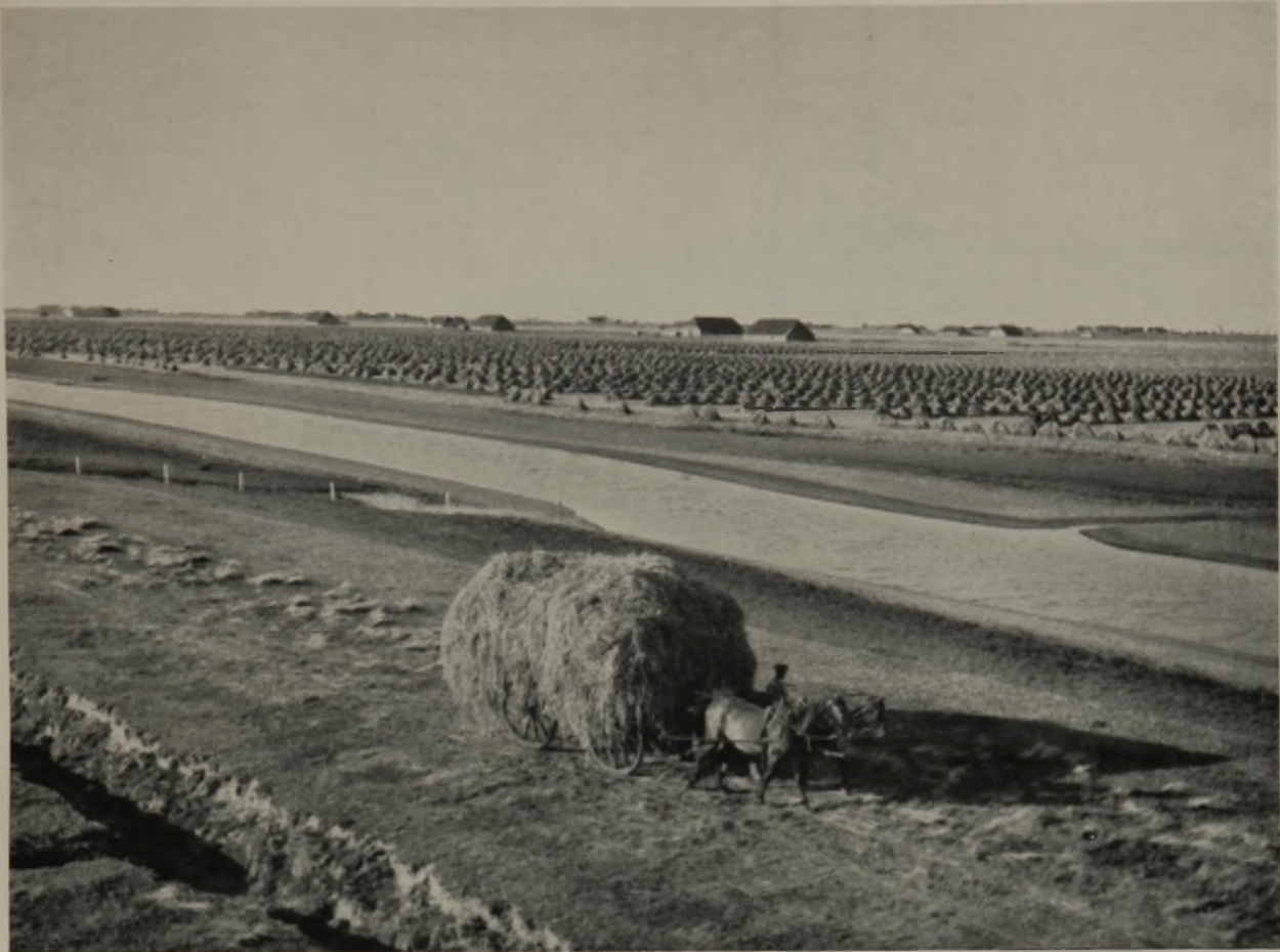
Anpassung der Häuser an das Gelände. Der Höhenunterschied erreicht nirgends 1 Meter
