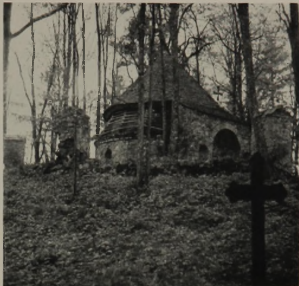
Familienbegräbnis in Zuckers, Rundbau aus Feldsteinen
