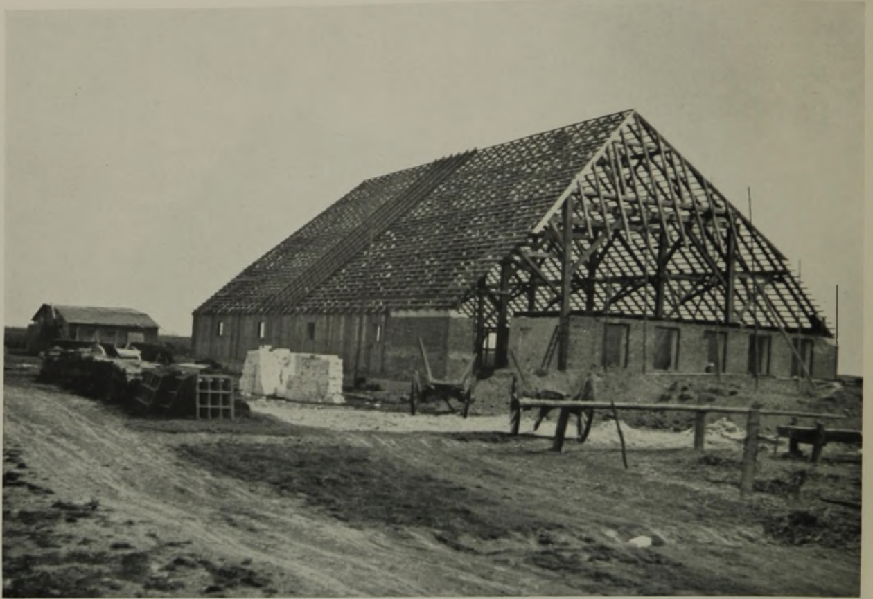
Ein Bauernhaus, fertig gerichtet und gelattet. Im Hintergrund die erste Wohnung der Siedler
