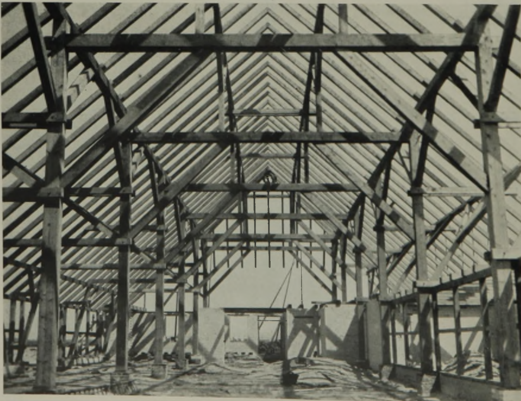
Blick in den Bansenraum (Grundfach) des fertig gerichteten Hauses
