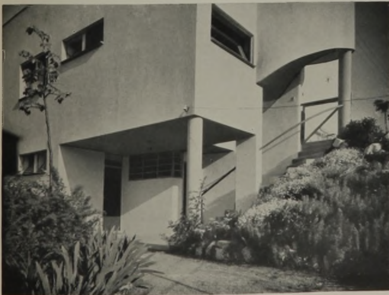
Blick von Nordwesten
