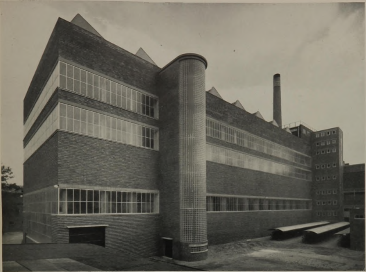
Ostseite des Sortiergebäudes
