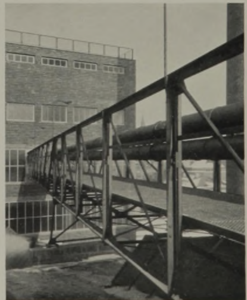
Gehbrücke und Wolltrockenlager
