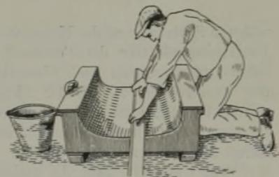
Abbildung 5. Glatstreiben der Formmasse in einer Kastenhälfte.
