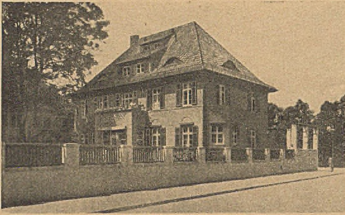
Gartenansicht des Hauses Fabricius in München-Herzogpark (In Gemeinschaft mit Architekt Arthur Hahn)
