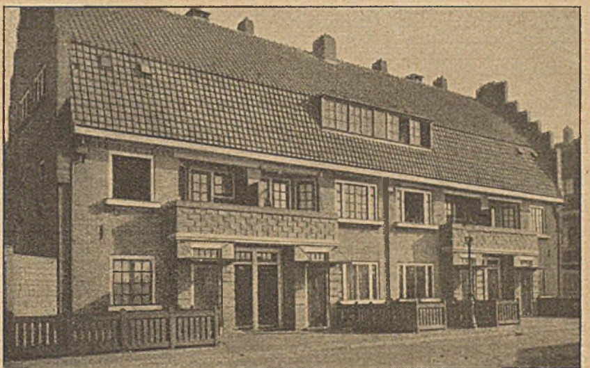
Abb. 6. Häusergruppe in der Schalksburgerstraat, Arch. J. Gratama. Häusergruppen aus Amsterdam. Vom Internationalen Städtebau-Kongreß in Amsterdam.
