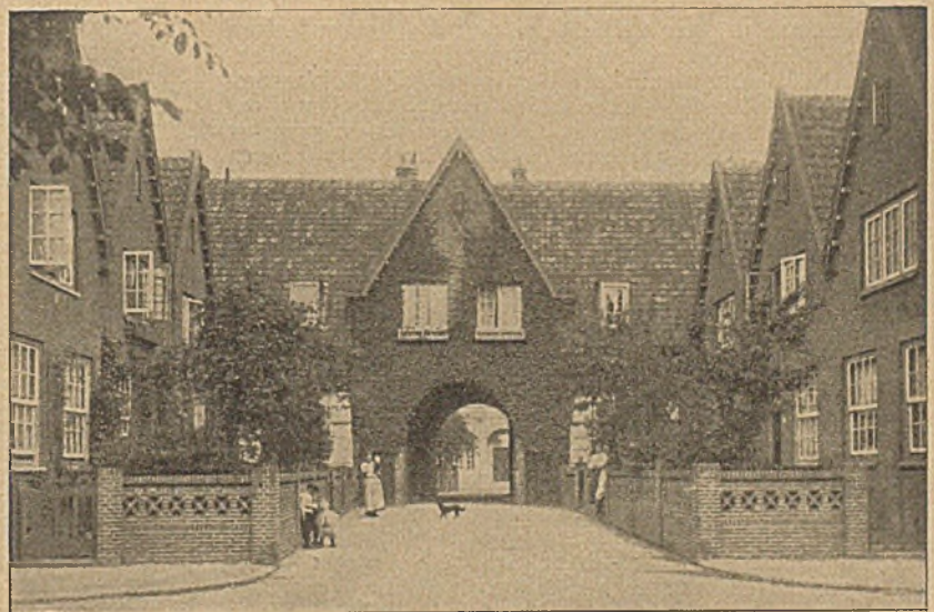
Abb. 29. Wohnhäuser in der Bisonstraße im Gartendorf Heyplaat bei Rotterdam. Arch. Baanders.
