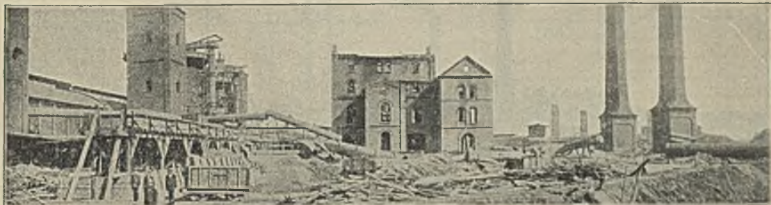
Abbildung 12. Die durch Explosion zerstörte Hochofenanlage der Friedenshütte (1887).
