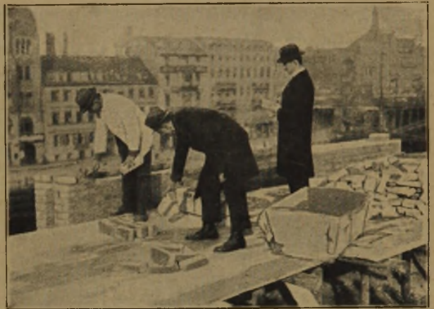
Abb. 4. Zeit- und Leistungsstudien zur Feststellung der günstigsten Arbeitshöhe beim Mauern.
