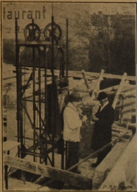
Abb. 1. Zeitstudien im Baubetrieb bei Aufzügen.
