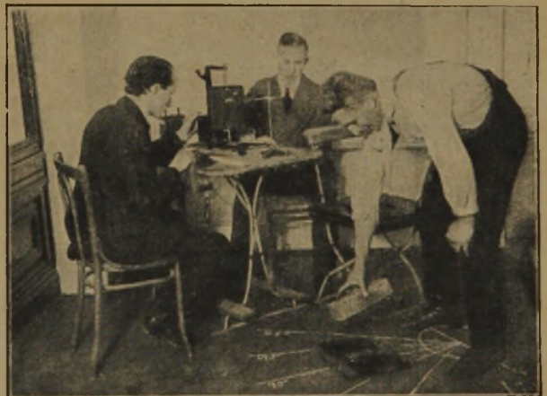
Abb. 6. Laboratoriums-Versuche zur Bestimmung der besten Lagehöhe der zu vermauernden Ziegelsteine.
