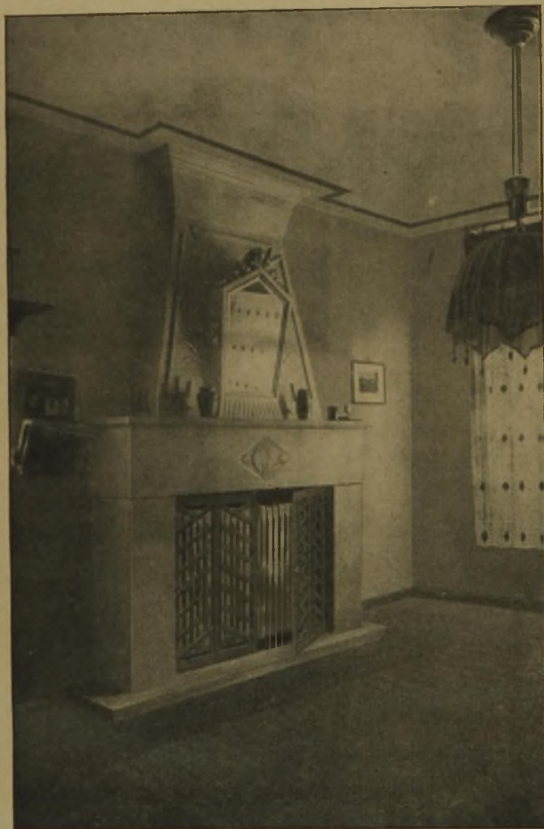
Abb. 2. National-Radiator Modell Classic, in kaminartiger Umrahmung eingebaut.
